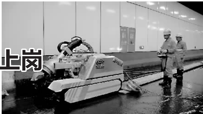
“龙吸水”设备正在作业。市城建集团隧桥公司供图
